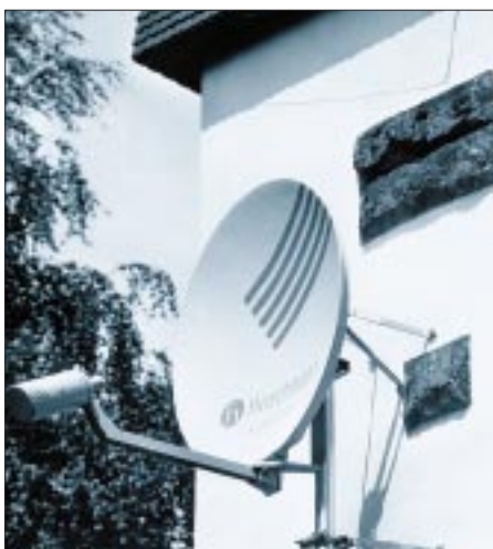
Stabile Halterungen für die Antenne und nicht-rostender Spiegel sind für Digitalempfang extrem wichtig. Sollte bei Altanlagen beides nicht mehr gegeben sein, ist ein Austausch zu empfehlen. Werkfoto Hirschmann
